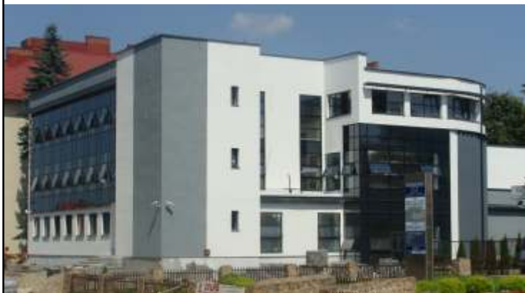
MODERNIZACJA I ROZBUDOWA JANOWSKIEGO OŚRODKA KULTURY W JANOWIE LUBELSKIM
