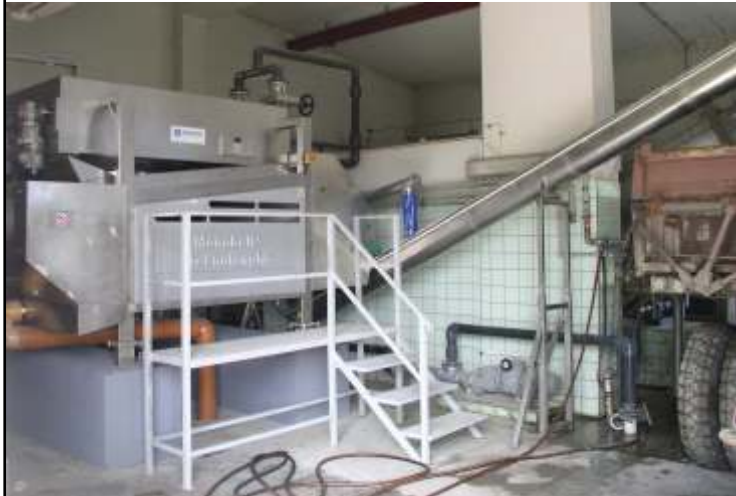
KONTYNUACJA KOMPLEKSOWEJ GOSPODARKI WODNO-CIEKOWEJ W JANOWIE LUBELSKIM - ETAP III
