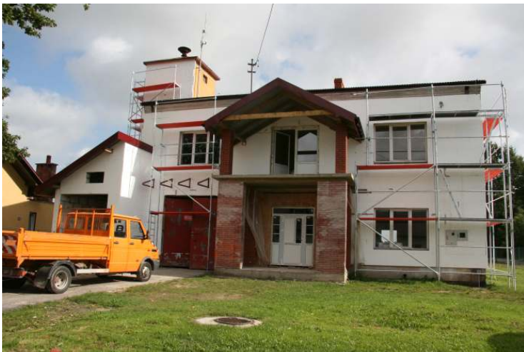
ROZBUDOWA BUDYNKU OSP W CELU UTWORZENIA CENTRUM KULTURALNO-REKREACYJNEGO W ZOFIANCIE GÓRNEJ
