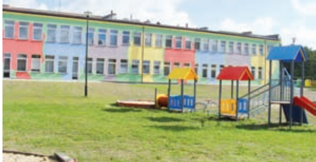
Termomodernizacja Przedszkola Publicznego nr 3 przy ul. Jana Pawła II
