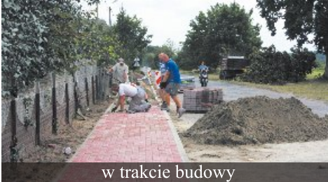
w trakcie budowy
